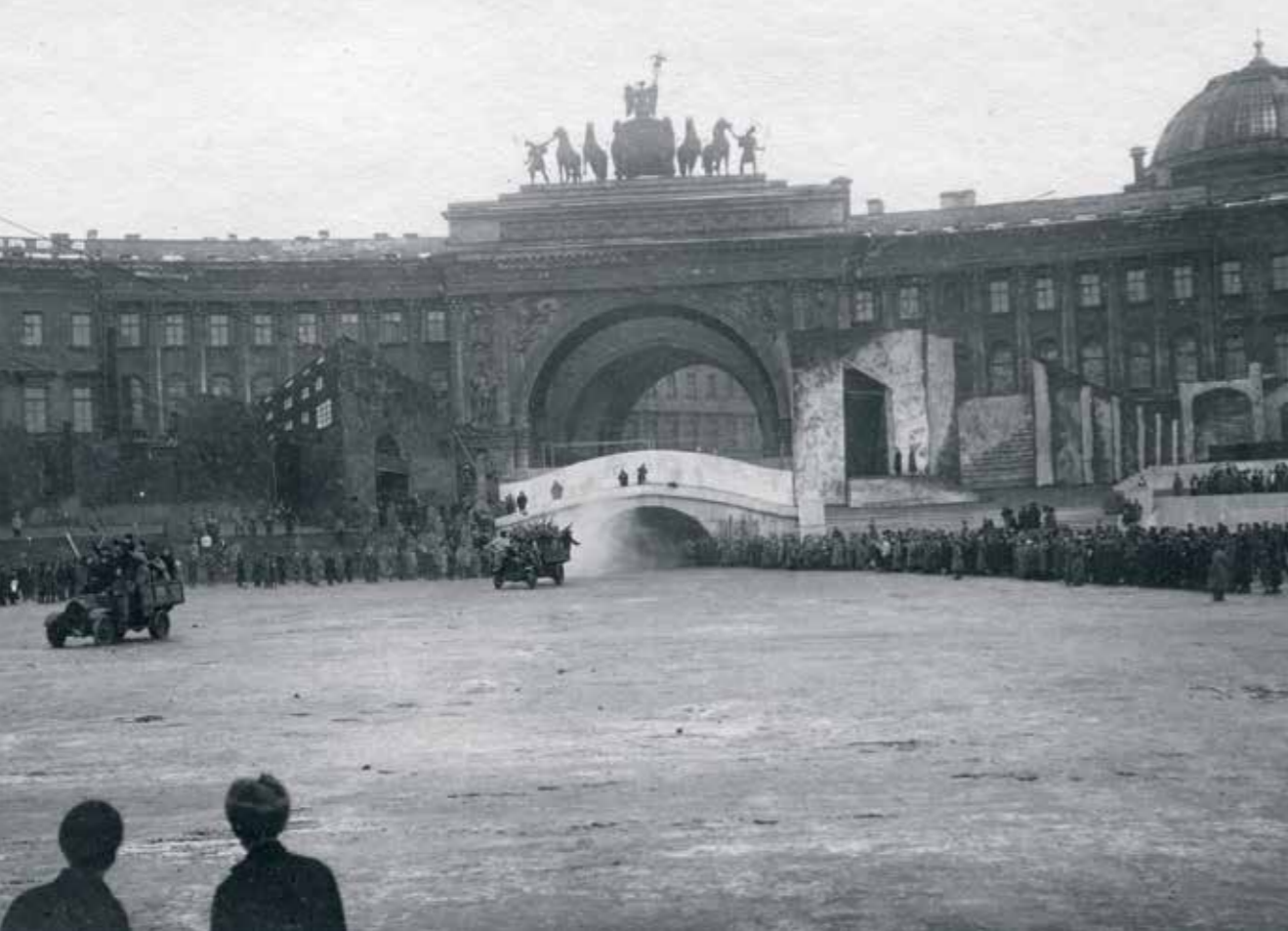
Blick auf die rückwärtigen Bühnen (links und rechts)
